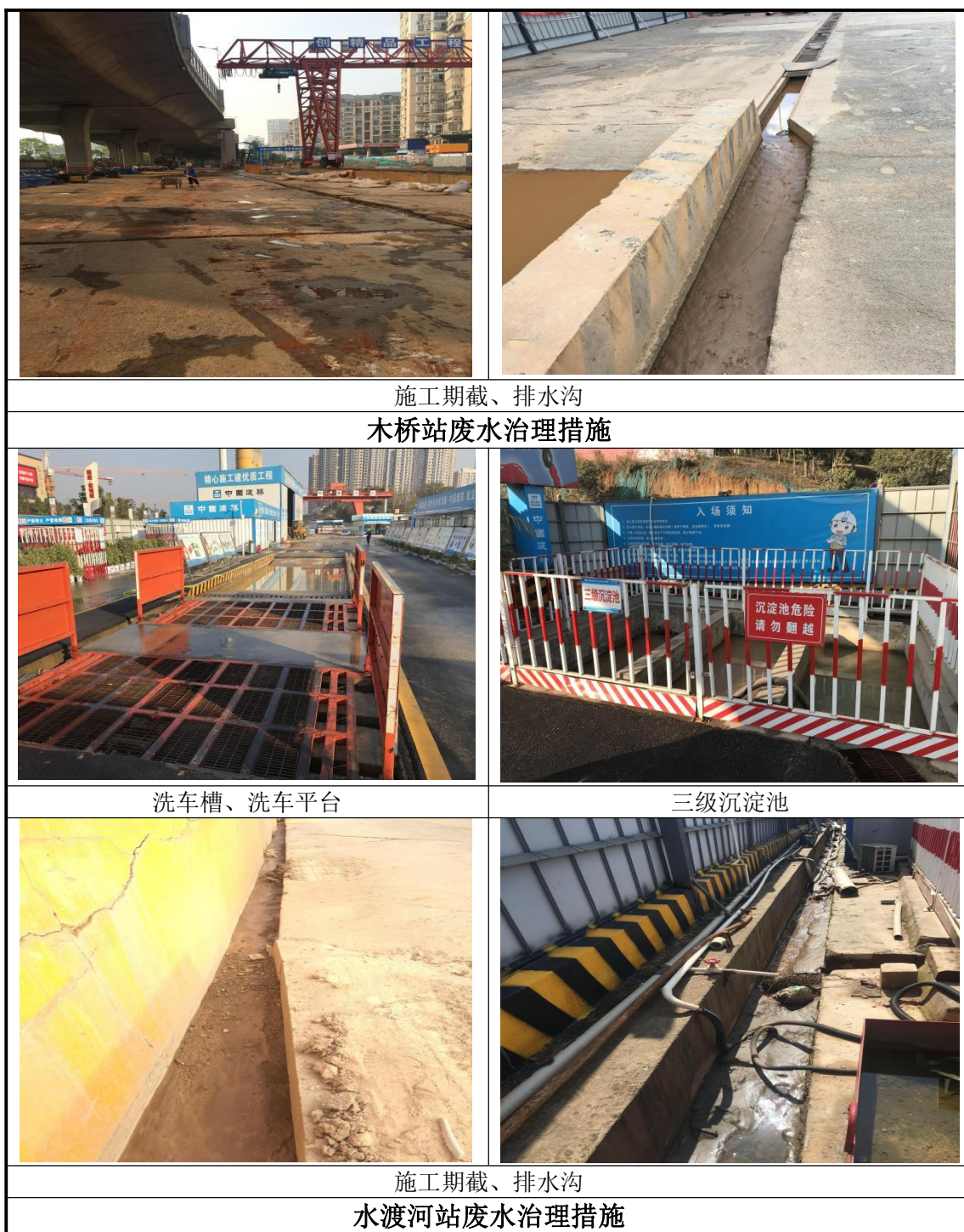
图 8.4-3 现有长沙市轨道交通 5 号线一期工程部分站点施工期水污染防治设施 8.4.1.2 生活污水
