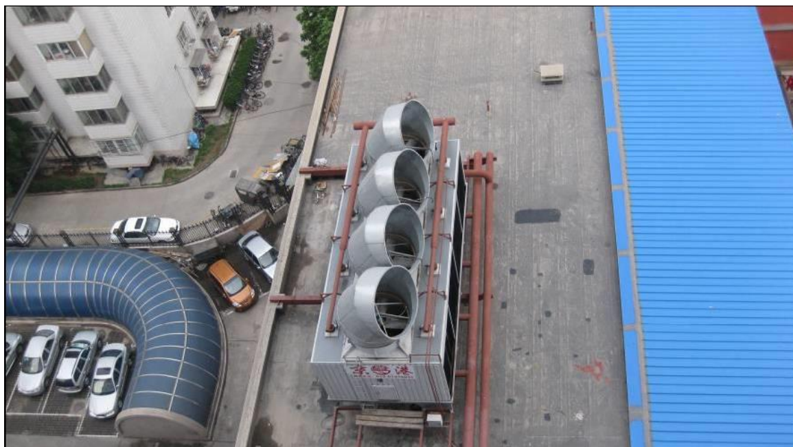
图 4.5-1 冷却塔导向消声器实施实例
