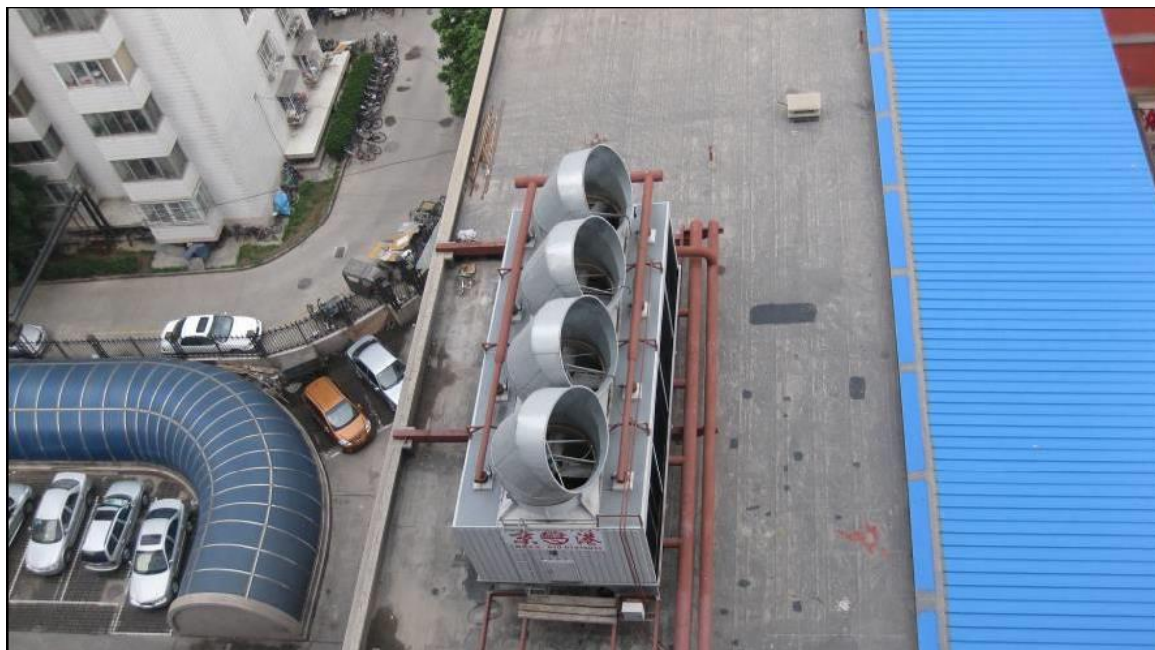
图 4.5-1 冷却塔导向消声器实施实例
