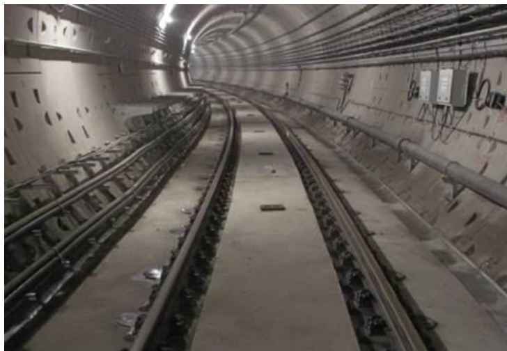
图 5.5-7 固体阻尼钢弹簧浮置板道床
